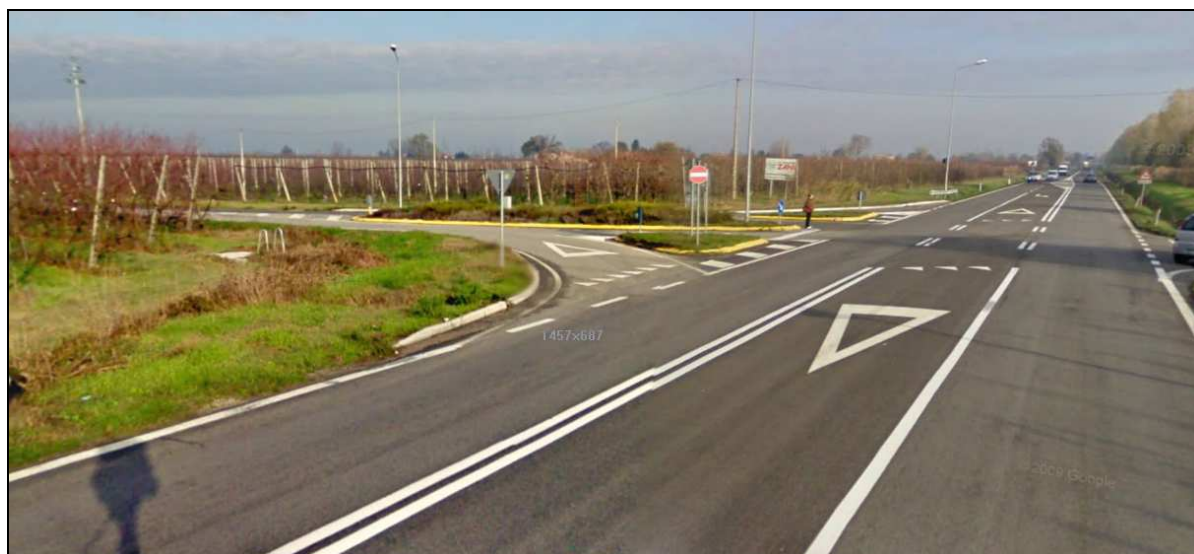
Fig. 5. – Vista, da via Granarolo, sull'intersezione con via Monte Sant'Andrea
